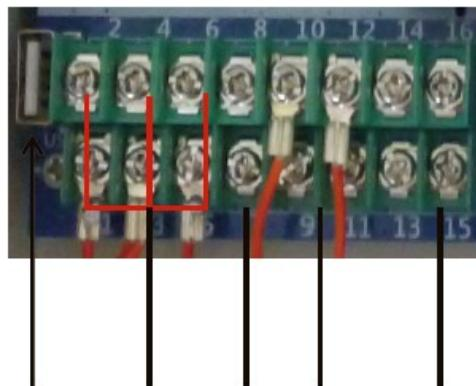
Клеммы для электрического подключения электрода/ поплавкового реле/ реле давления
