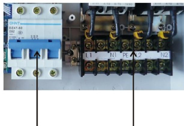
Основные контактные группы для электрического подключения к сети и подключения насоса
